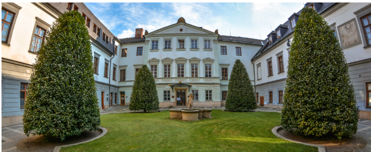
Budova Rektorátu Univerzity Palackého
